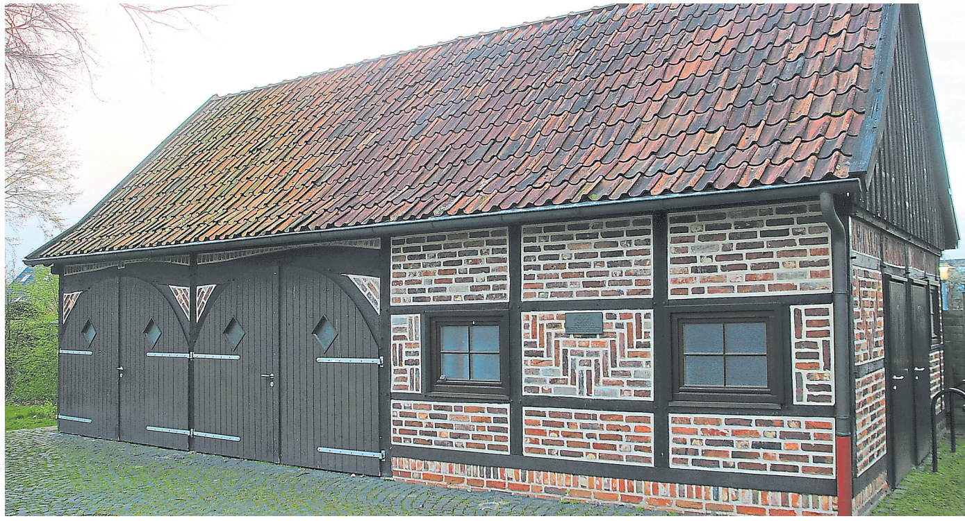
Zwölf Meter lang und sechs Meter tief: Die Spiekerscheune, mit deren Bau 2009 begonnen wurde, bietet viel Platz für Ideen.
